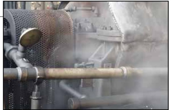
蒸汽轮机的蒸汽泄漏增加了蒸汽成本，并降低了效率和蒸汽轮机的性能。
